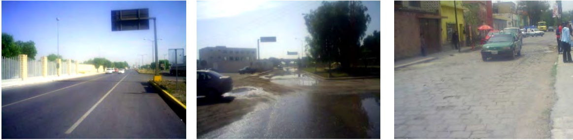
Avenida en condiciones excelentes - Zonas con encharcamientos requieren mantenimiento - Vialidad sección reducida c/adoquín
