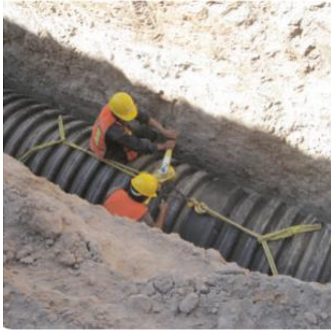
Fotografía En el Proceso de Construcción de Colector Pluvial
