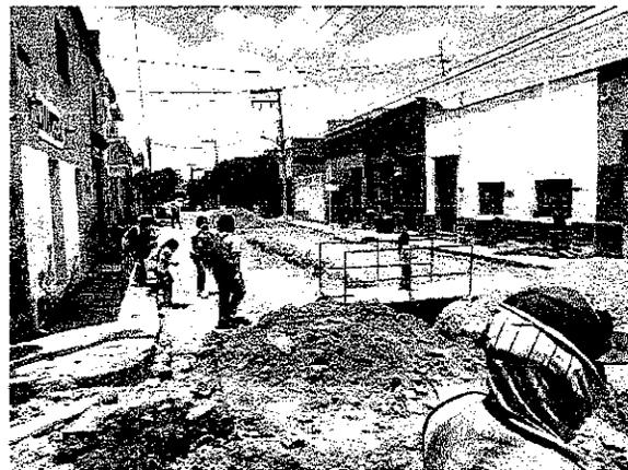
Dentro del proceso de las obras de rehabilitación de las calles materia de este juicio de amparo, se lleva a cabo la señalización de áreas de riesgo en el momento de realizar interconexiones o excavaciones en los cruces de calle, garantizando siempre la accesibilidad mediante pasos peatonales para el libre tránsito: de llevarse a cabo el cierre de calles por estas circunstancias, se realiza el señalamiento respectivo.
